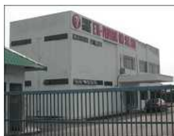
ETA - PADTRON (M) SDN BHD.(マレーシア)
